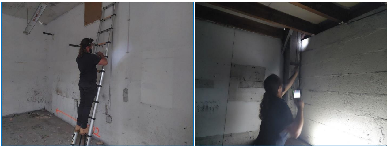
Figure 2 : Inspection des anfractuosités dans le bâti à l'aide, d'une échelle, d'une lampe et d'un endoscope
