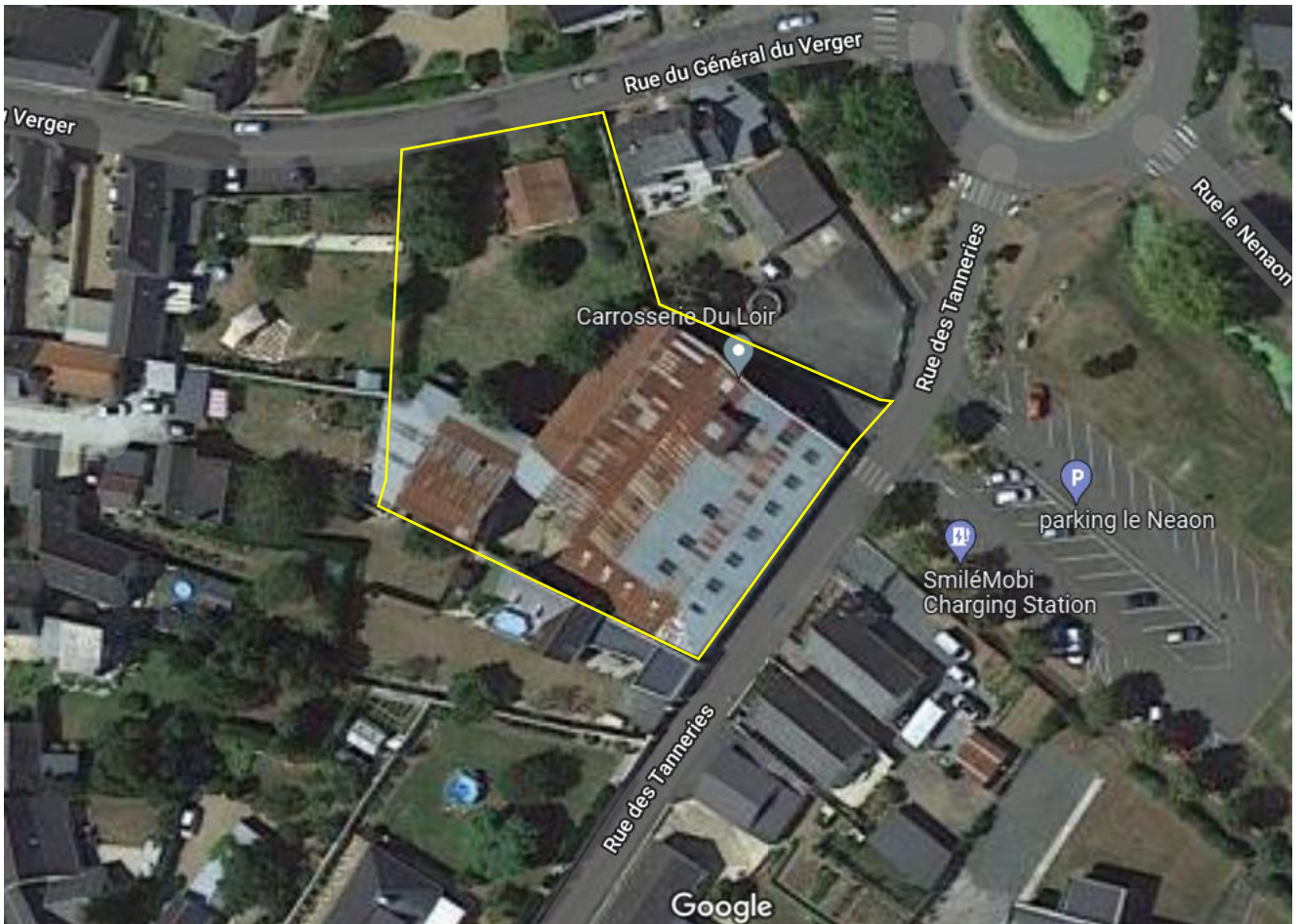
Détourage précis des bâtiments à démolir
